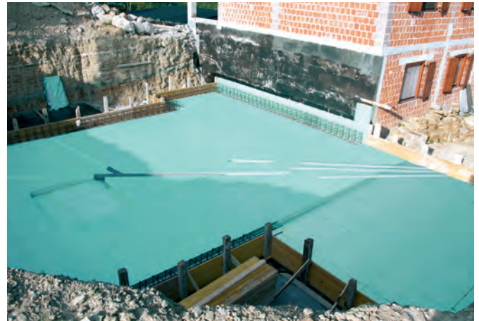
Instalação de algumas infraestruturas em canais previamente abertos nas placas de isolamento térmico FIBRANxps 400-L.
