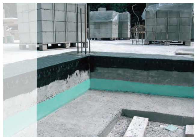
Pormenor 10 – Impermeabilização betuminosa na laje de fundação de um edifício com cave. Isolamento térmico FIBRANxps 400-L sob a laje de fundação.
