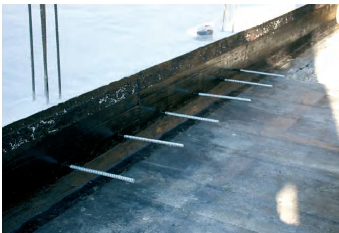
Pormenor 3 - Elementos prefabricados, como poços de luz devem ser instalados de acordo com as indicações do produtor. A penetração causada pela ancoragem do poço de luz necessita de ser evidentemente selada. A construção deve ser isolada termicamente da zona fria da entrada de luz.
