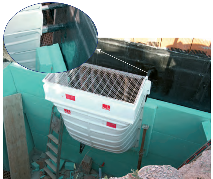
Pormenor 3 - Elementos prefabricados, como poços de luz devem ser instalados de acordo com as indicações do produtor. A penetração causada pela ancoragem do poço de luz necessita de ser evidentemente selada. A construção deve ser isolada termicamente da zona fria da entrada de luz.
