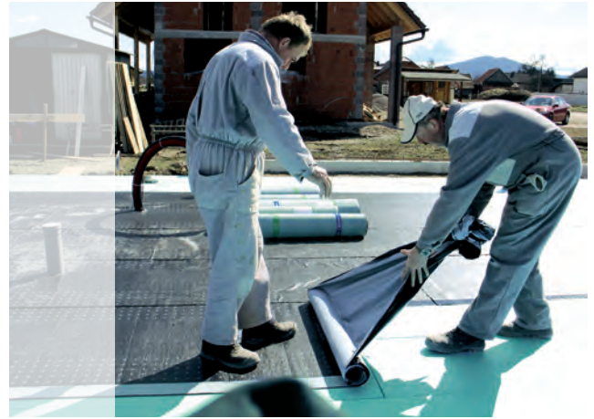
Aplicação de impermeabilização auto-adesiva em placas de isolamento térmico FIBRANxps 400-L
