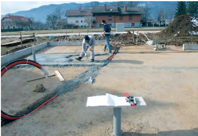
Introdução das infraestruturas, compactação e nivelamento do terreno onde assentará a primeira camada de isolamento térmico FIBRANxps.
