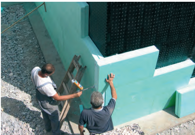
Aplicação de FIBRANxps 300-L com correcto encaixe nas juntas cruzadas.
