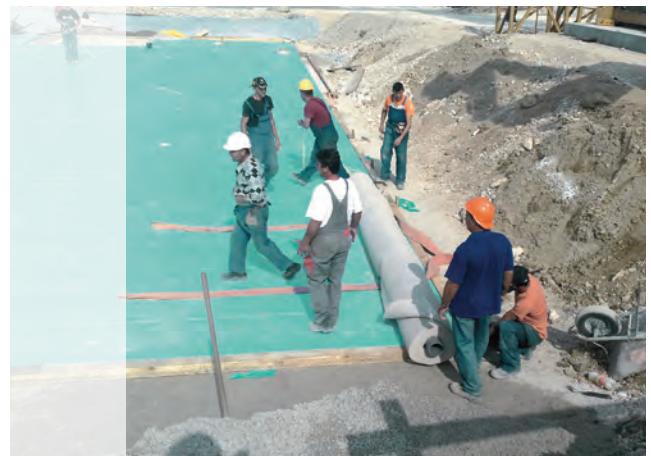
Pormenor 8 – Impermeabilização colocada sob FIBRANxps 400-L antes da construção da laje de fundação de um edifício escolar.
