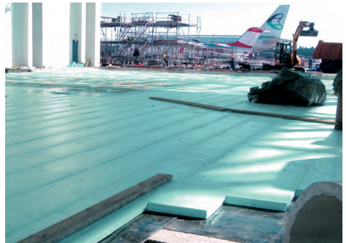
Isolamento térmico de um hangar para aviões com FIBRANxps 700-L
