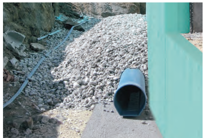
Para garantir um desempenho ótimo do isolamento térmico é recomendável a instalação de um adequado sistema de drenagem ao longo de todo o elemento isolado permitindo a drenagem das águas pluviais e do solo.
