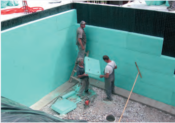
Colagem de placas de FIBRANxps 300-L com adesivos de borracha butílica.
